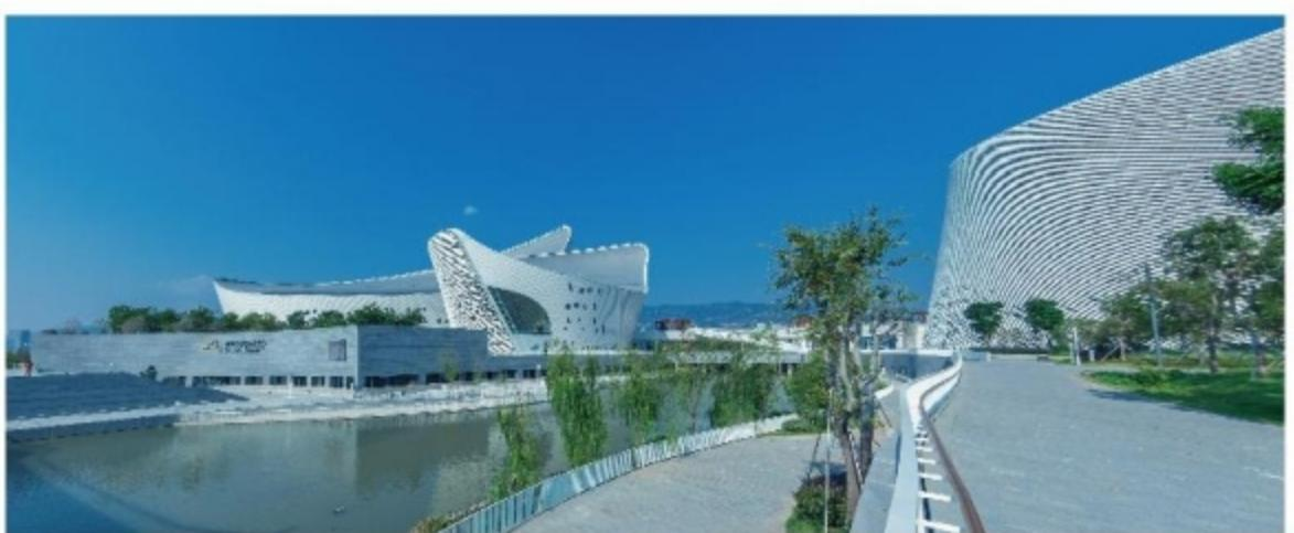
**主立面的陶瓷百叶是透镜状的**，与建筑的体块形式有关。它们最大化地为巨大的玻璃幕墙立面提供了遮阳。在复杂的软件的帮助下，建筑师研究了百叶之间的距离和角度，从而达到了百叶立面的最佳效果。
